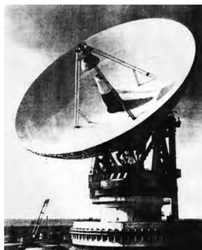
Рис. 2. Приемно-передающая полноповоротная антенна диаметром 70 м Центра дальней космической связи в Крыму, используемая для планетного радиолокатора СССР с 1980 г.
