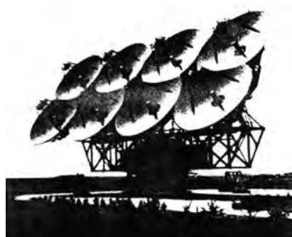
Рис. 16. Антенна Центра дальней космической связи, использовавшаяся в планетном радиолокаторе СССР до 1980 г.
